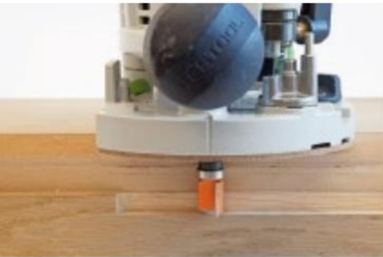
Die Ausfräsungen für die Tritt- und Setzstufen wurden mit einem Bündigfräser der Firma CMT in die Wange gefräst.
